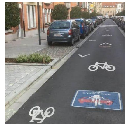
1_ Rue Sneessens/Baucq, Etterbeek Sneessensstraat / Baucqstraat, Etterbeek
